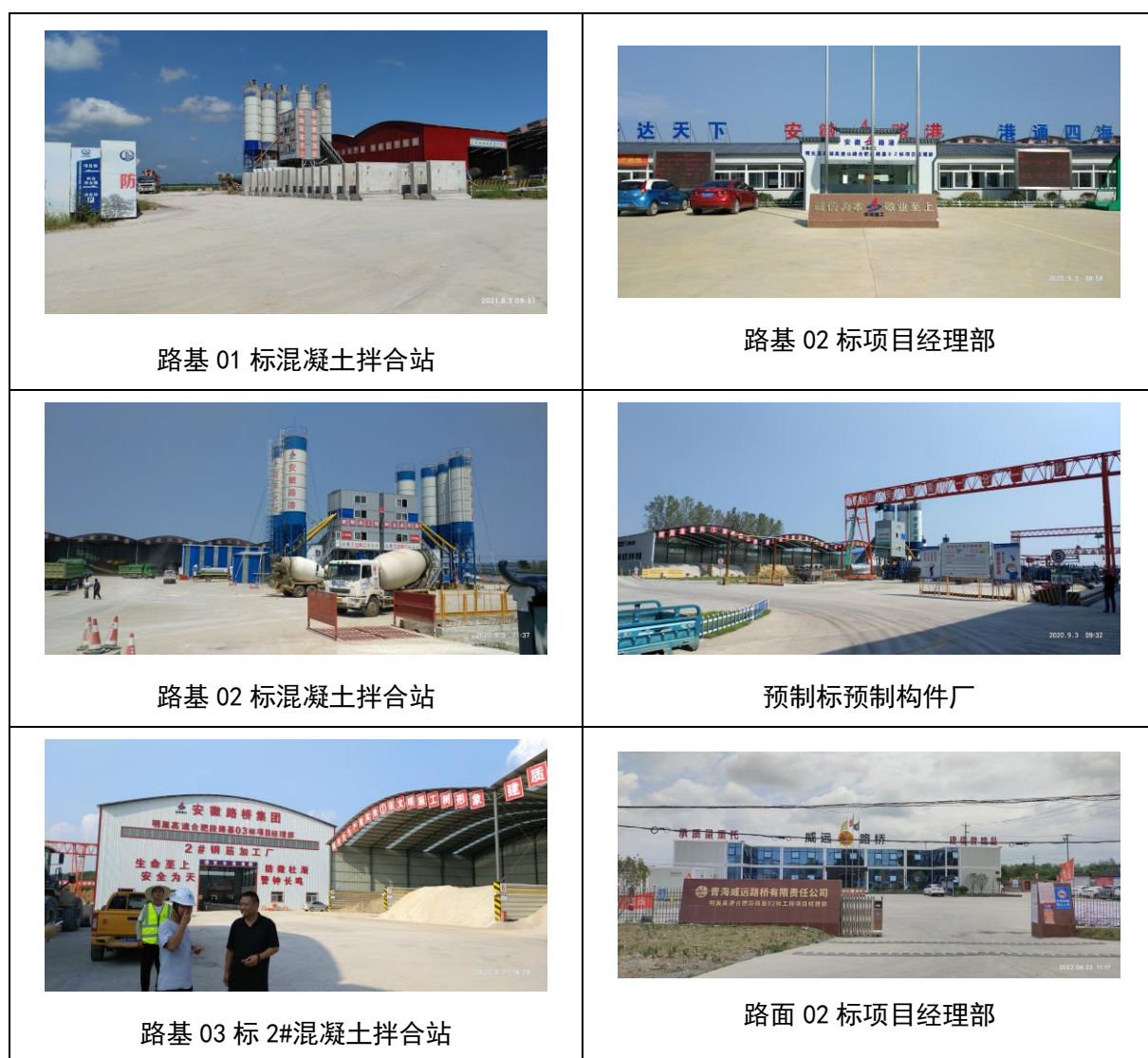
图 9.1-1 施工期临时场站环境卫生状况照片
