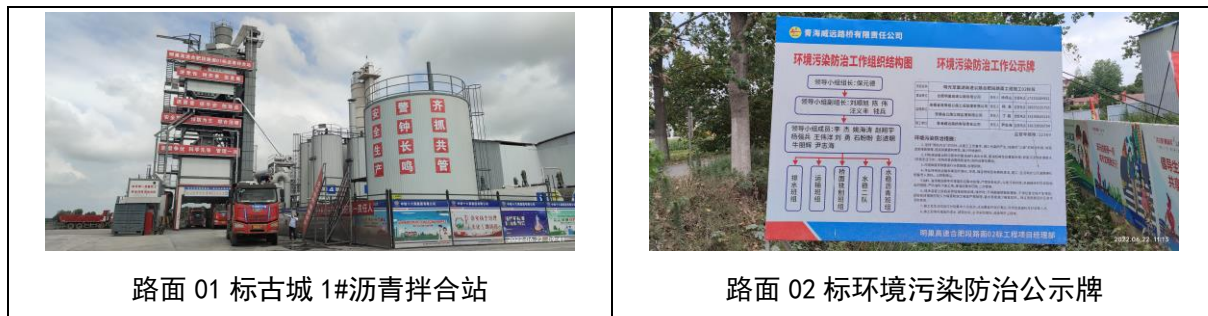
图 7.1-1 施工期扬尘污染防治措施照片
