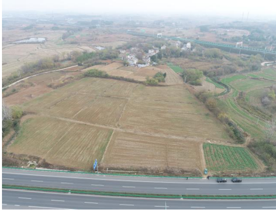
路基 03 标临时工棚、搅拌站
