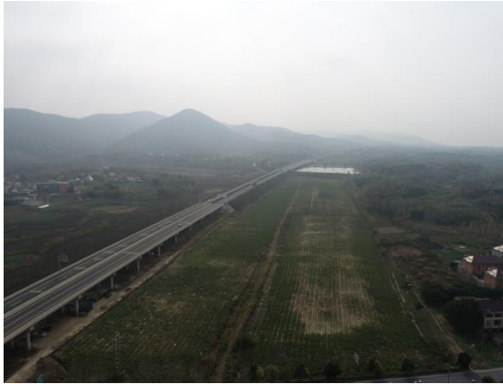
路基 02 标预制场及钢筋加工场
