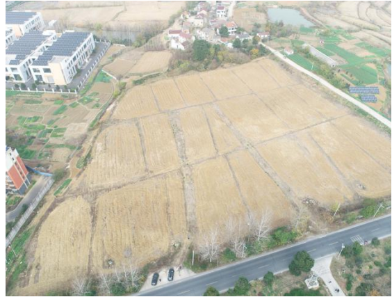
路基 02 标项目部及拌合站
