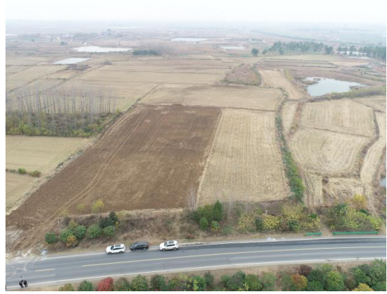
路基 01 标项目部、混凝土拌合站
