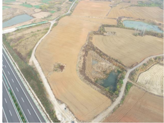
路基 03 标预制梁场及拌合站
