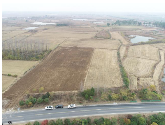
路基 01 标项目部、混凝土拌合站
