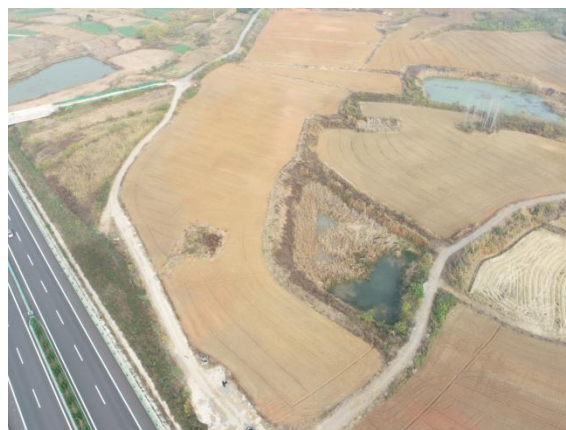
路基 03 标预制梁场及拌合站
