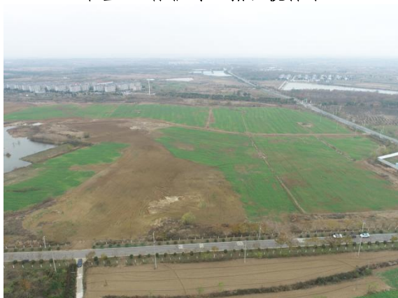
路面 01 标水稳站、沥青拌合站
