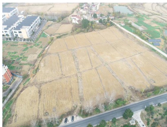
路基 02 标项目部及拌合站
