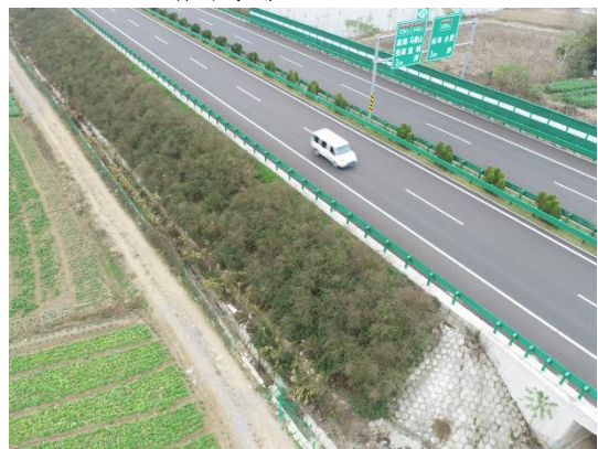
路基排水、防护 (2024.12)
