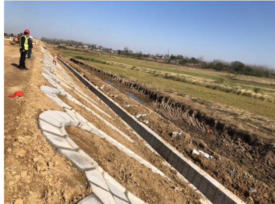
骨架护坡、路基排水 (2021.11)
