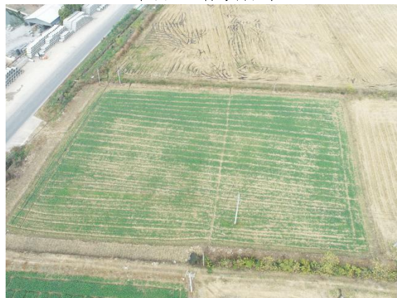
预制标临时工棚、拌合站及预制场
