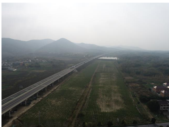
路基 02 标预制场及钢筋加工场
