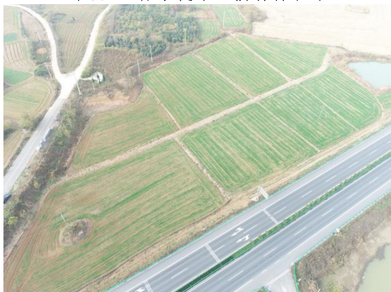
路面 02 标水稳站
