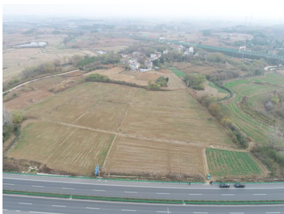
路基 03 标临时工棚、搅拌站
